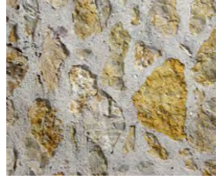
Moellons enduit garnissant
