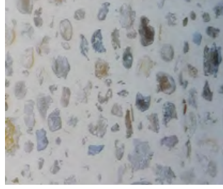
Galets et pierres tout venant recouverts d'enduit
